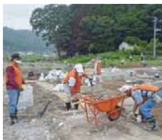
土砂崩れて埋もれた家屋は、土台が見えるまで土砂とがれきを撤去
