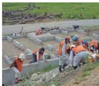
土砂崩れて埋もれた家屋は、土台が見えるまで土砂とがれきを撤去
