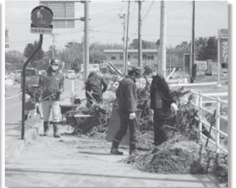
通学路の泥の掻き出し作業 (相馬市)
