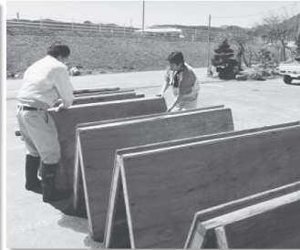
床板の天日干し作業 (宮古市)
