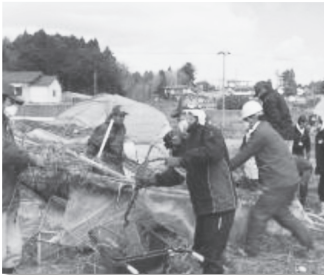
ビニールハウスの解体・撤去作業 (相馬市)
