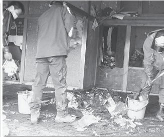
自宅の土砂撤去作業 (気仙沼市)
