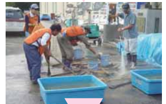
機材の洗浄・返却
