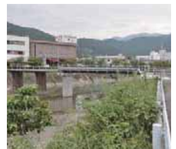
熊野市労働福祉会館裏の線路
