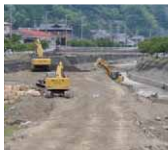
井戸川の復旧作業
