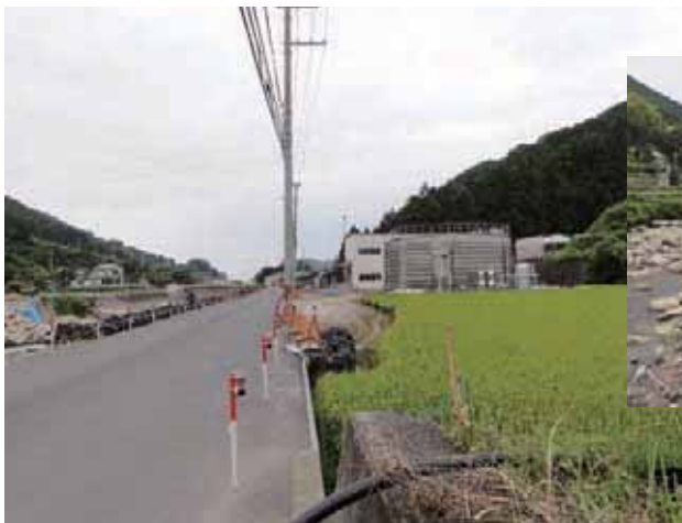
上水道井戸浄水場前（熊野市）
