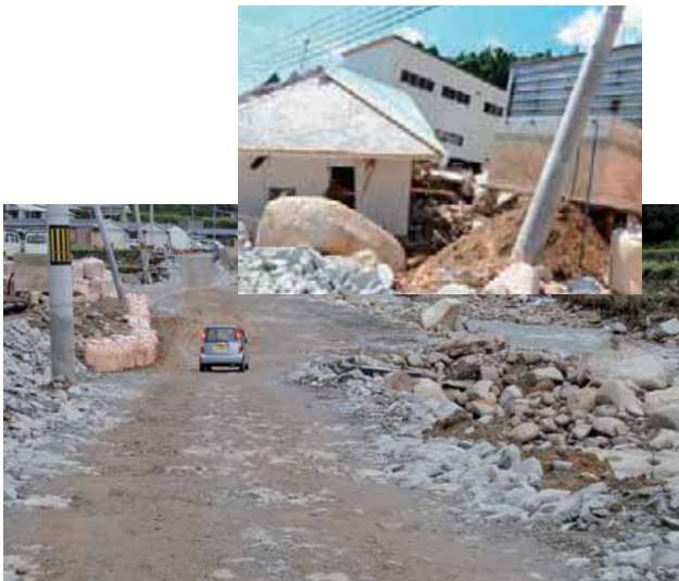
上水道井戸浄水場（熊野市）
