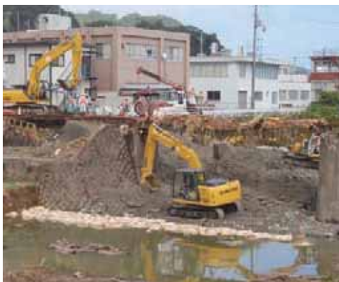
熊野市労働福祉会館裏の線路
